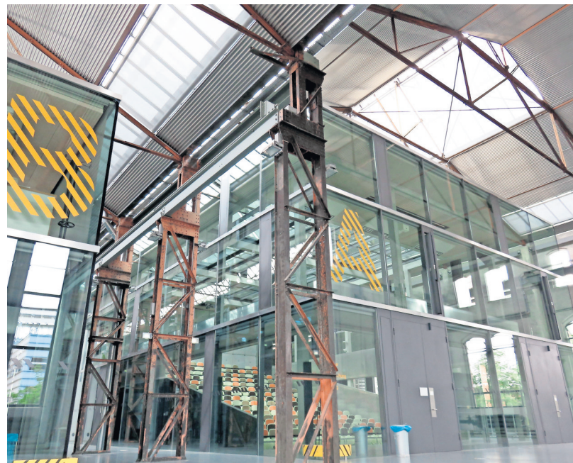
Vor zehn Jahren wurde auch die von Anderhalten Architekten umgebaute Halle 14 als Instituts- und Laborgebäude mit großem Hörsaal eingeweiht.
