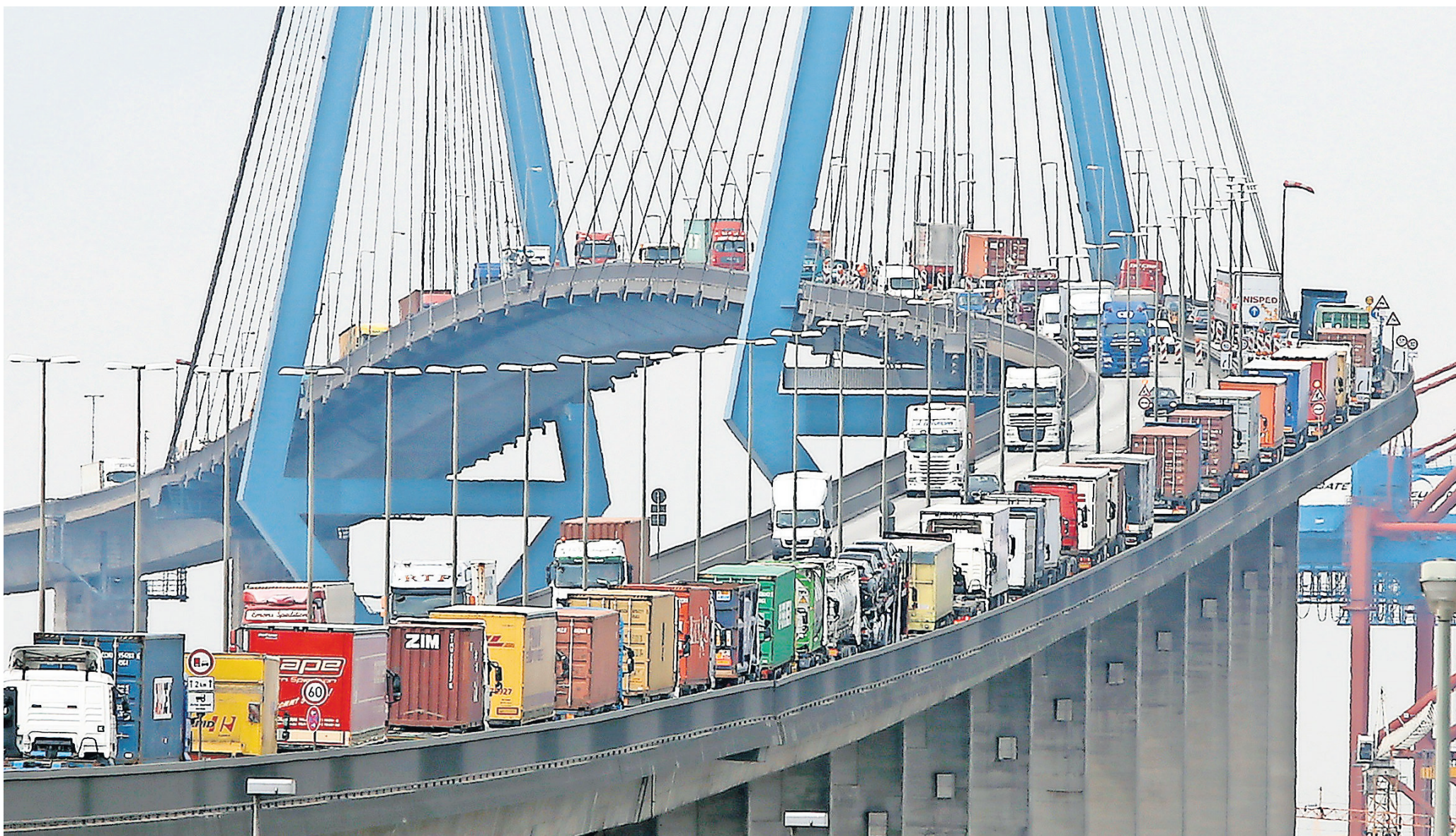
Stau auf der Köhlbrandbrücke im Hafen von Hamburg: In einem umfassenden Projekt ermitteln TH-Verkehrslogistiker, woher all diese Lastwagen eigentlich kommen.
