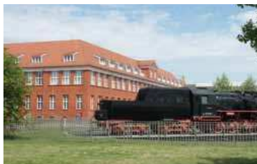
Ansicht des Campus der TH Wildau
