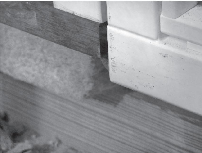
Abbildung 8: BlowerDoor – Überdruck und Nebelgerät
