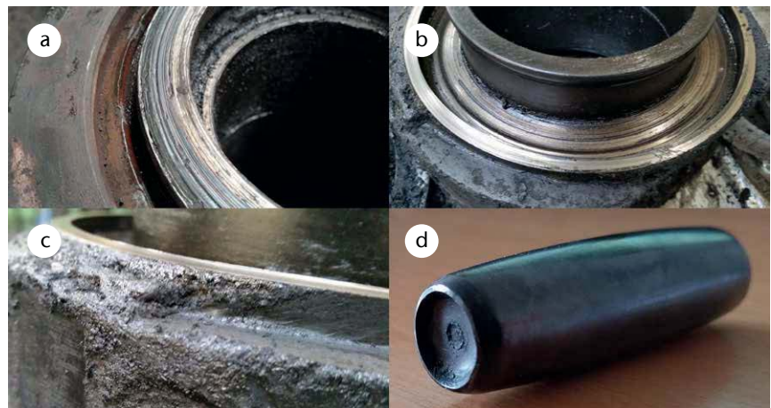
Abb. 9) Zusammengefasste Schadensbilder bei der Demontage der Rolleneinheit
