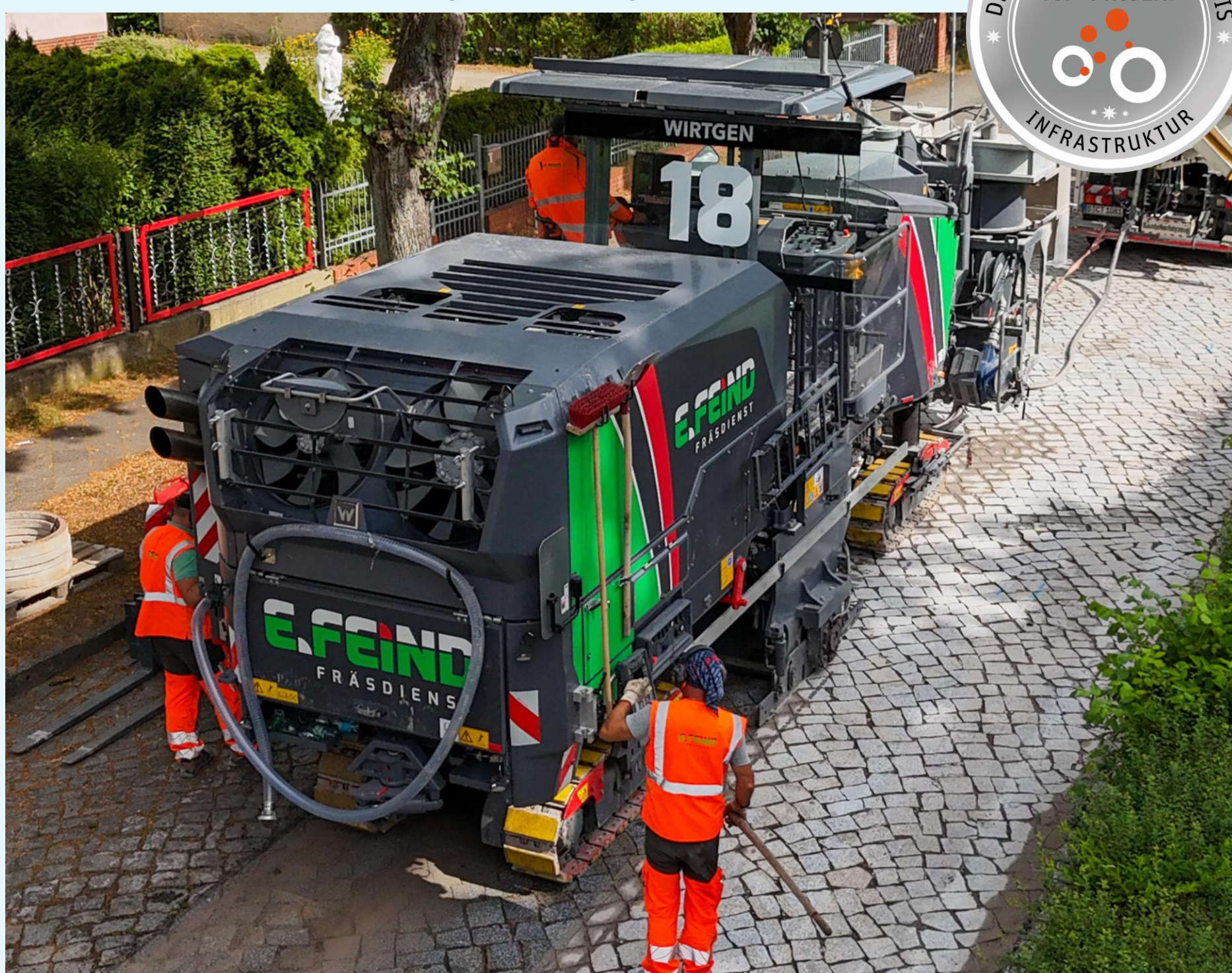
Abschleifen von Kopfsteinpflaster in der Gemeinde Eichwalde durch Fräsdienst-Service E. Feind
