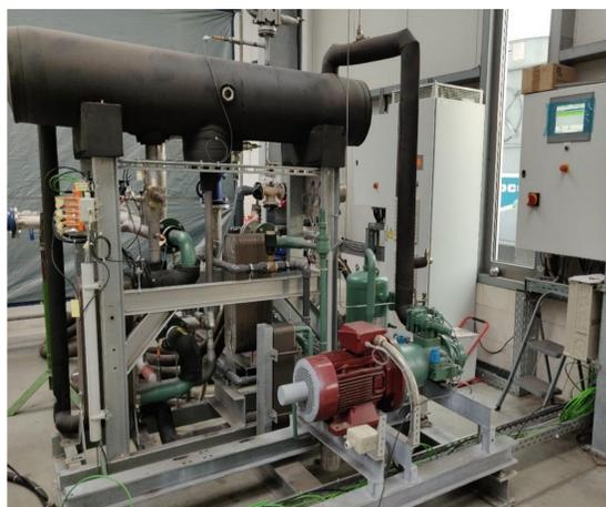
Aufbau-Sicht auf Verdichter, Schaltschrank Verflüssiger und Kältemittelabscheider
